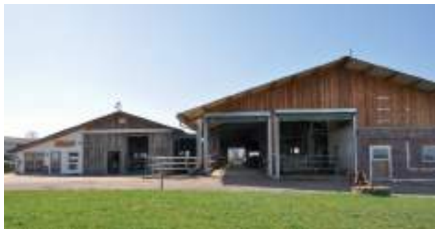
Der alte und der neue Stall auf dem Schneiderhof.
