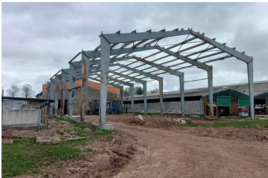
Nově budovaná porodna
