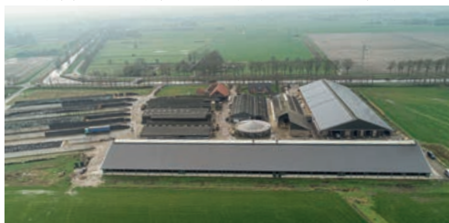
Nová stáj v popředí, starší stáj (vpravo nahoře) byla nyní osazena solárními panely
